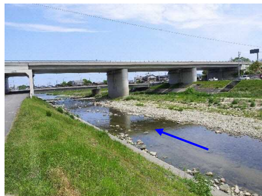
湊川下流域 高松自動車道付近から下流を望む （河口から 2.9 km 付近）
