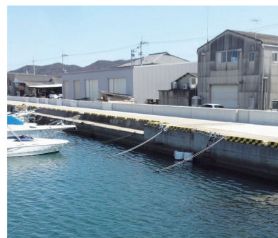
地震・津波対策事業の施工現場(志度港)
