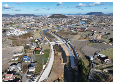
河川工事の現場
