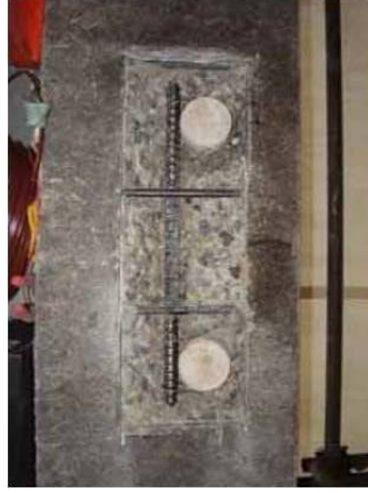
ガルバニウムXP設置(マクロセル対策)
