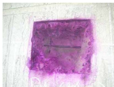
はつりによる中性化深さ測定
