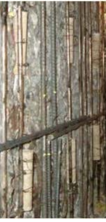
ガルバニールCC135設置状況(断面修復部への適用)
