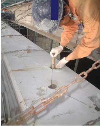
ガルバニウムXP設置(コア削孔)
