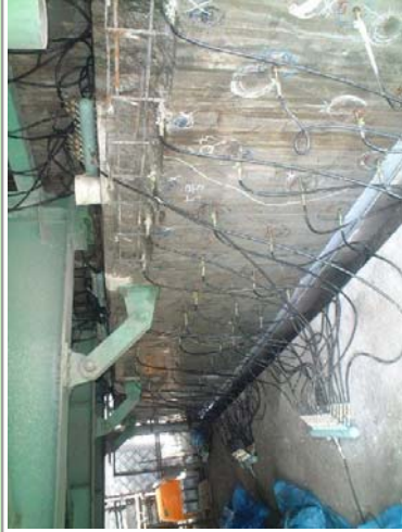
【本加圧注入工施工状況】
