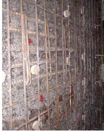
ガルバニウムXP設置(全面設置)
