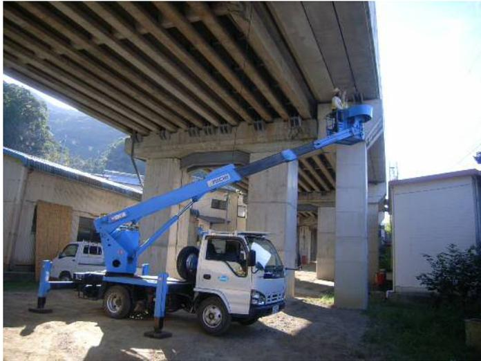
写真-5.1 高所作業車による点検の例
