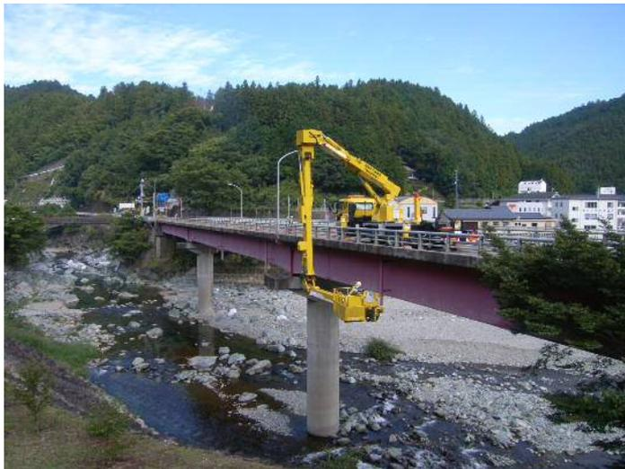
写真-5.2 橋梁点検車による点検の例
