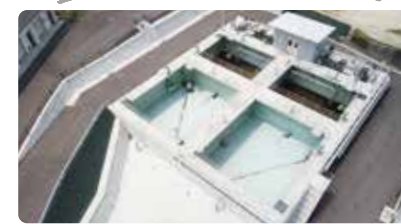
浅野浄水場急速系排水池 排泥池築造工事
