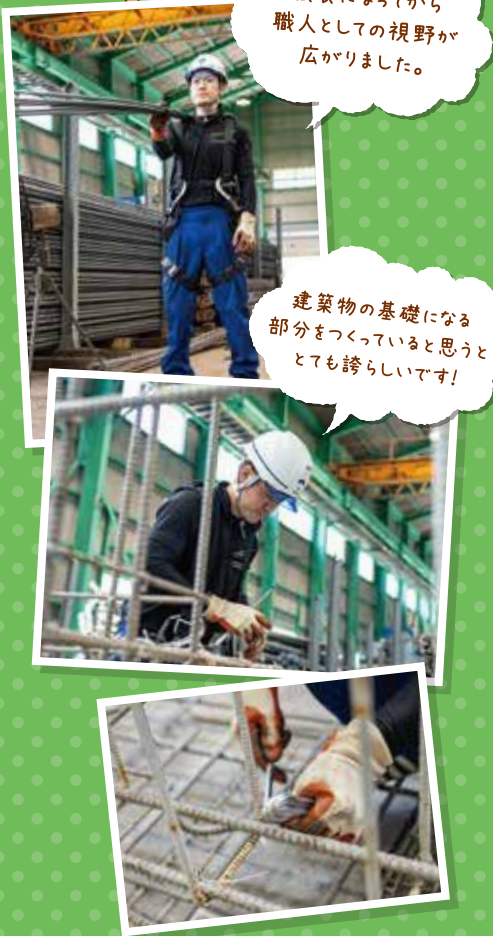
武田建設株式会社内 鉄筋組立現場にて
