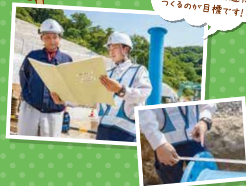
御殿配水池付近 土留め擁壁・ 落下防止柵・配管工事現場にて
