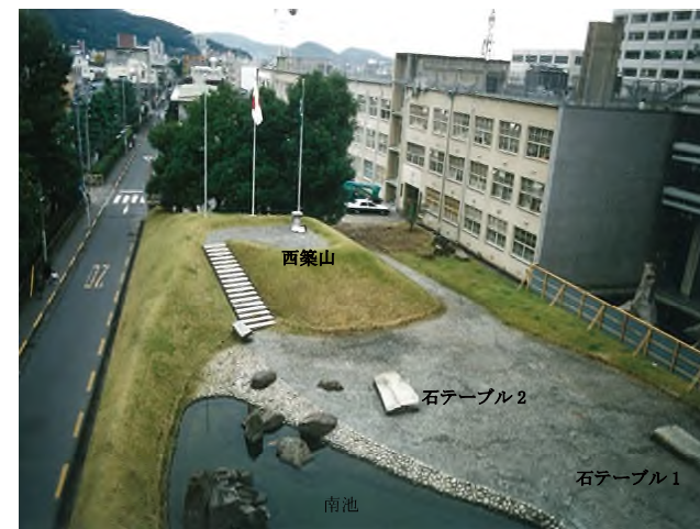
【写真① 全撤去前の西築山の形状 (香川県所蔵)】
