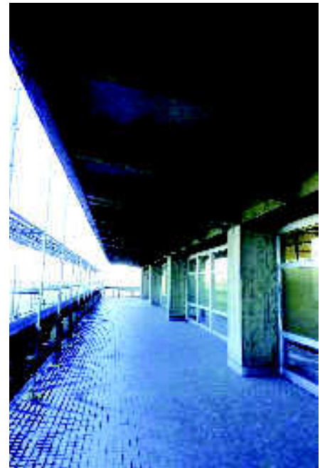
写真6 2階庇の大梁・小梁
