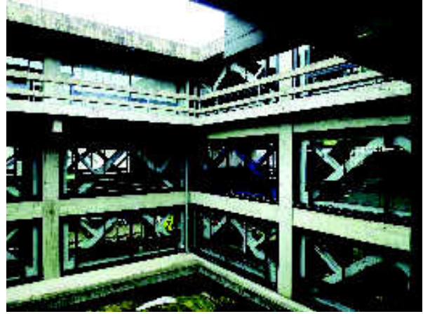
写真10 倉吉市庁舎 耐震施工例
