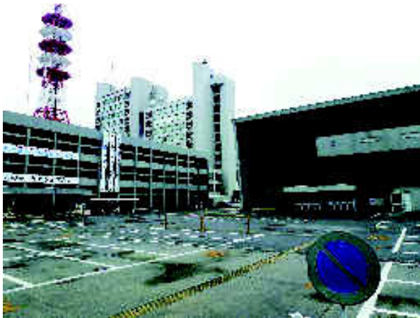
写真7 今治市庁舎（左）・公会堂（右）、広場（手前）
