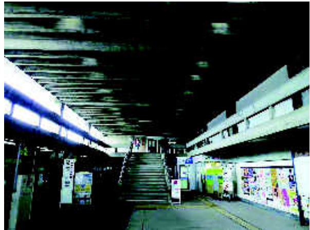
写真4 市民ホールの現状
