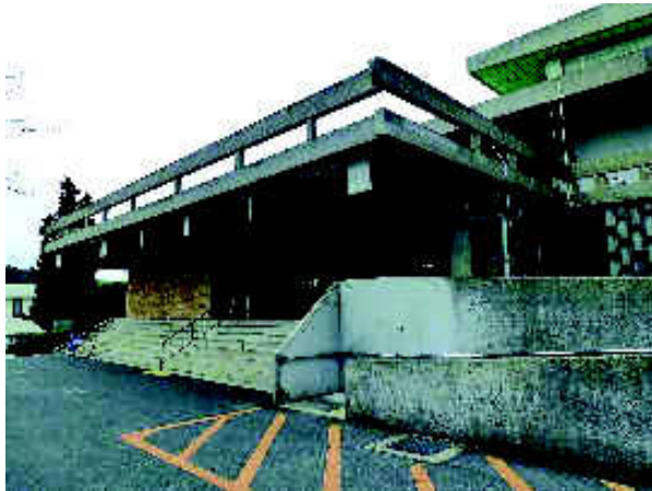
写真3 市民ホールの現状
