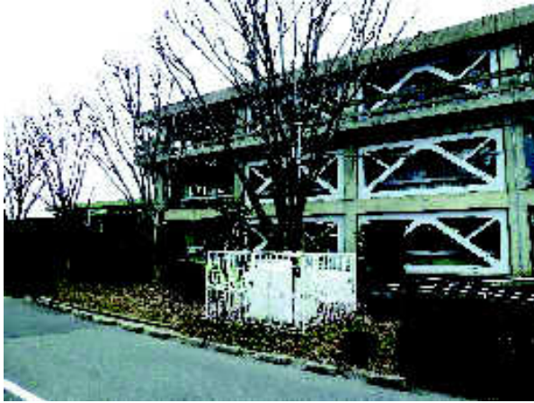
写真9 倉吉市庁舎 耐震施工例
