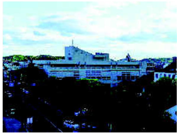
写真8 倉敷市庁舎（手前が広場）
