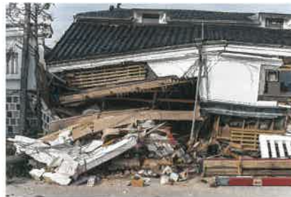
地震による被害例 (能登半島地震)
