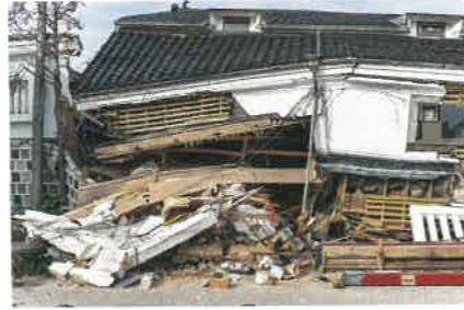
地震による被害例 (能登半島地震)
