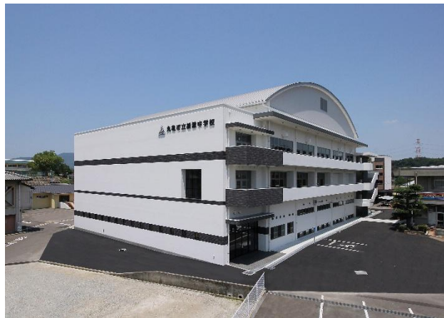
丸亀市立綾歌中学校屋内運動場(R7.6)
