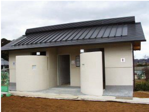
亀鶴公園南公衆便所 (H15.3)
