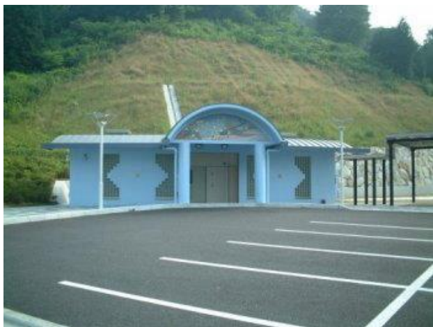
道の駅「空の夢もみの木パーク」便所棟 (H14.4)
