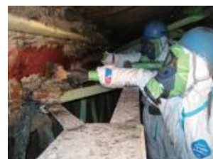
吹付け石綿の除去作業の様子
