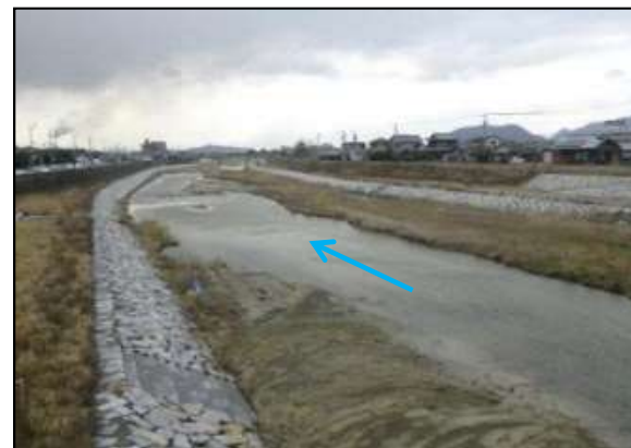
写真① 下流(鴨川新橋付近)
