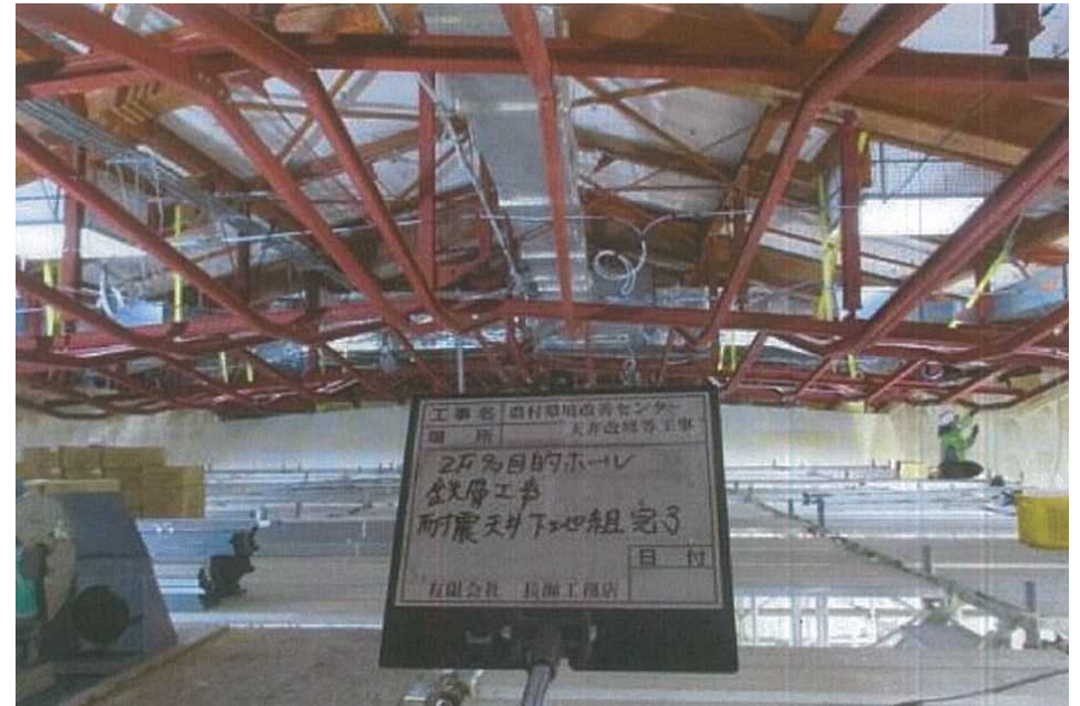
③ 着工後(天井鉄骨)
