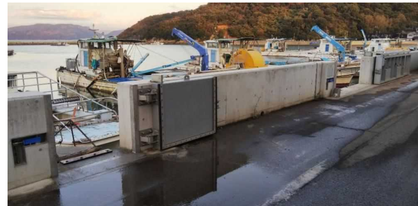
陸 閘（胸壁区間）
