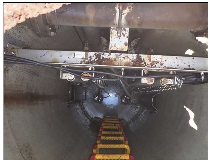
マンホールポンプ 目視調査
