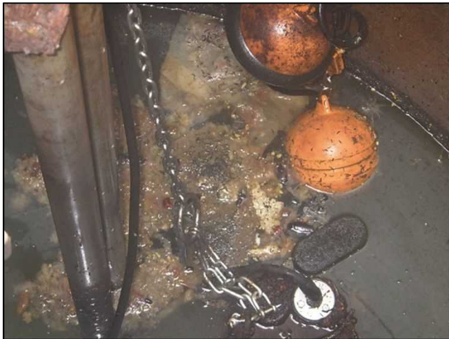
目視調査 ポンプ付近状況
