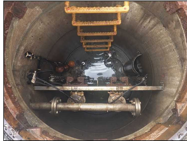
マンホールポンプ 目視調査
