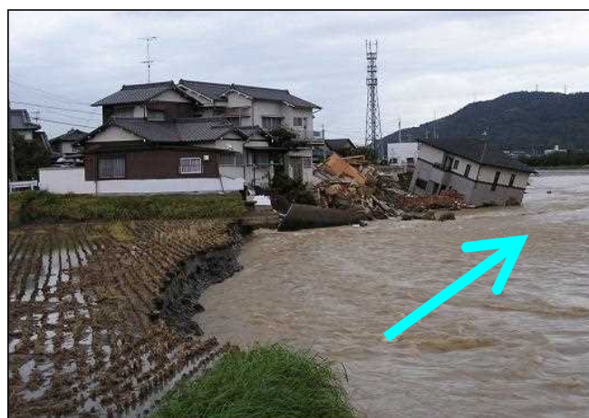
村田井堰上流付近
