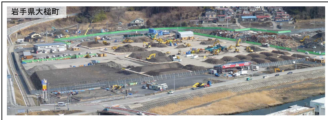
図 2-6-(10)-3 二次仮置場の例
