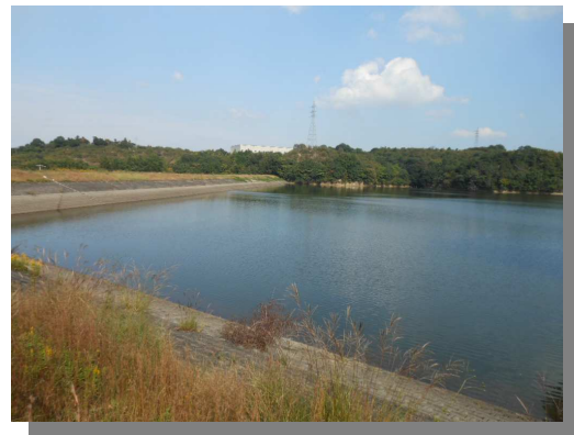
西側から堤体を望む
