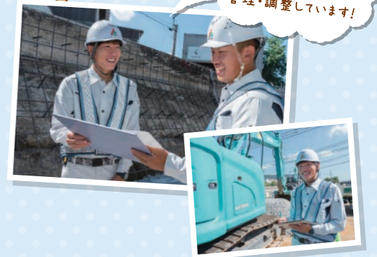
高松市内 御坊川 護岸工事現場にて
