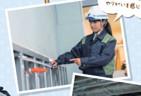
高松市 医療施設 新築工事現場にて
