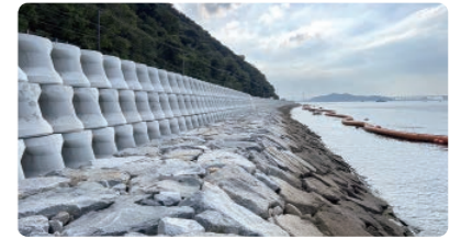
土砂災害対策事業 県道高松市越坂出線 道路整備工事
