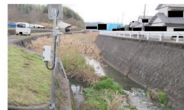
(簡易型河川監視カメラ)
