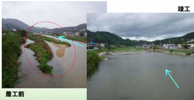
津田川 河道掘削事業 【県】さぬき市津田町(樹木伐採・河道掘削)
