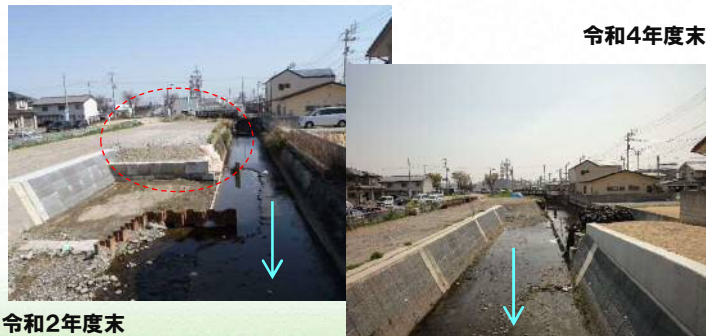
桜川 河川改修事業 【県】多度津町(護岸整備等による河川改修)
