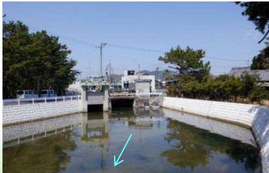
梅川 地震・津波対策海岸堤防等整備事業 【県】さぬき市津田町(津波・高潮対策)
