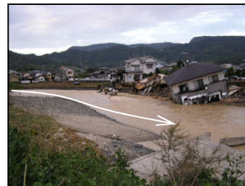
平成 16 年台風 23 号被災状況
