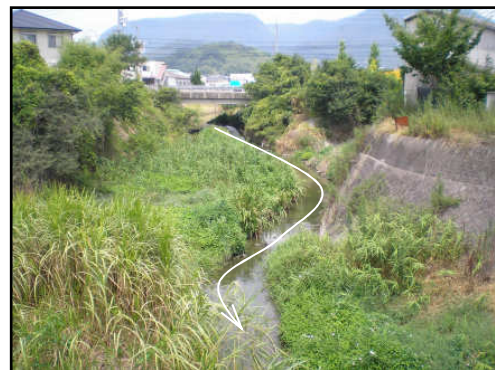
本津川上流 万灯橋から上流を望む (河口から 8.1km 付近)
