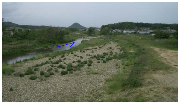
綾川中流 綾上橋から下流を望む (府中湖上流端から 5.6km 付近)
