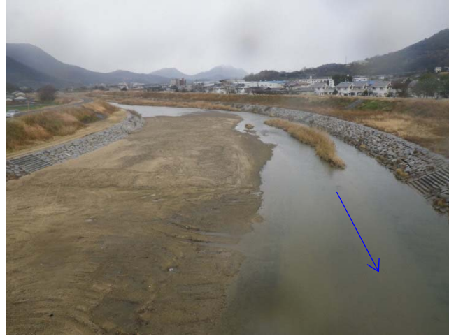
綾川 河川整備状況（河口から 3.9km 綾川橋付近）
