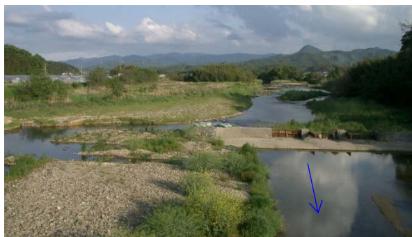
綾川中流 宮武橋から上流を望む (府中湖上流端から 1.7km 付近)
