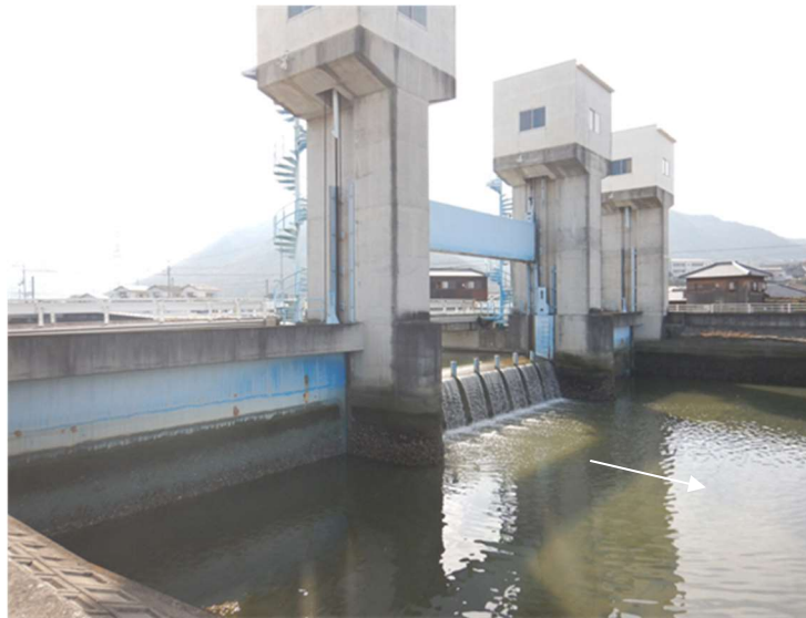
弘田川防潮水門 (河口から約 0.7km 付近)
