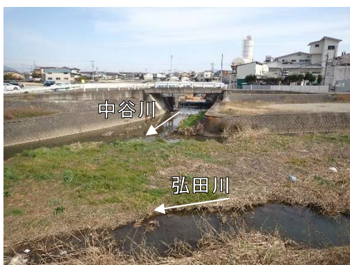
弘田川・中谷川合流点 (河口から 5.5km 付近)
