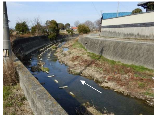
弘田新橋下流 (河口から 3.9km 付近)
