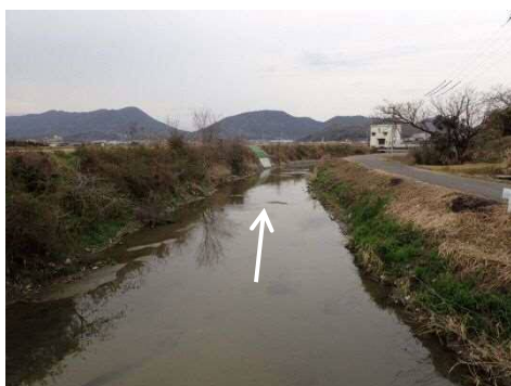
浜堂川 JR 浅津川橋梁下流 (高瀬川合流点から 1.7km 付近)
