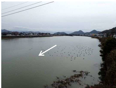
詫間水門上流 (河口から 1.6km 付近)
