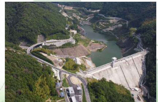
柵川ダム 建設事業 【県】高松市塩江町（新たなダムの建設）
