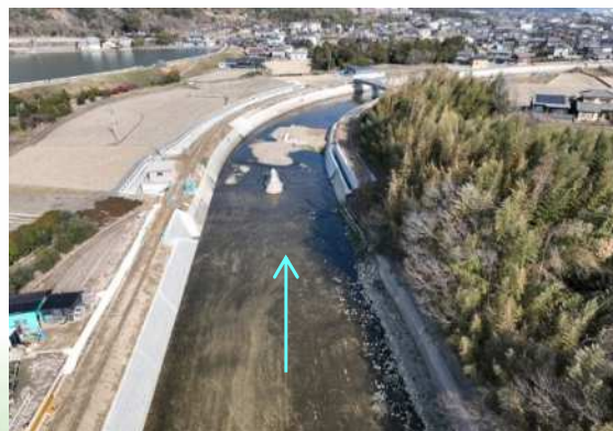
本津川 河川改修事業 【県】高松市 (護岸整備等による河川改修)
