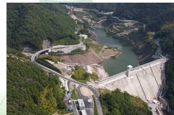
椋川ダム 建設事業 【県】高松市塩江町(新たなダムの建設)
