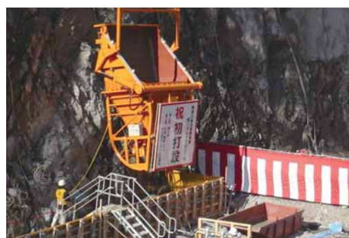
②ダム本体コンクリート初打設 (H28. 12. 2)
