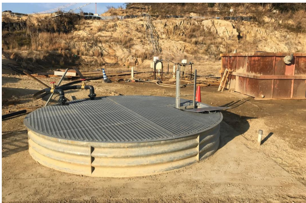
写真1 集水井施工状況 (H31. 1. 19 撮影)
