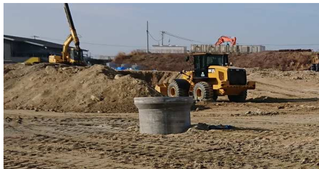
写真 1 井戸側の設置状況
