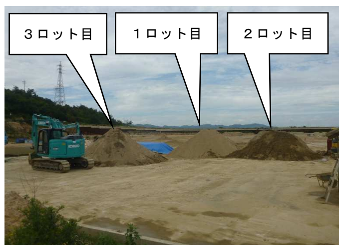
写真 1 洗浄浄化後の土壌（コンクリートヤード南側から撮影）
