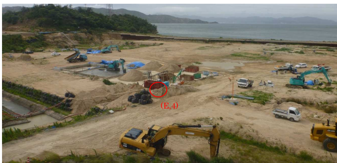
写真1 施工状況（H30.7.3撮影）
