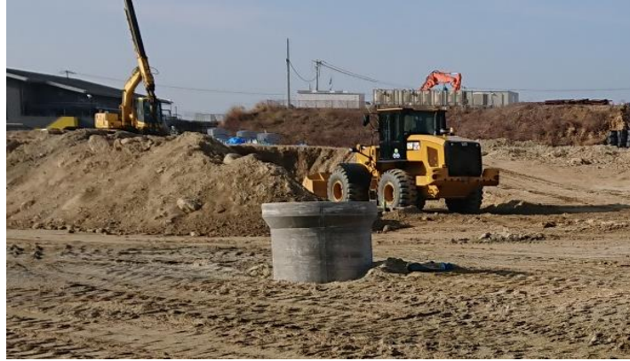
写真 1 井戸側の設置状況
