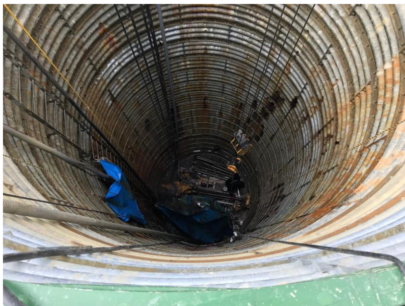
写真1 横ボーリング施工状況 (H30.6.12撮影)
