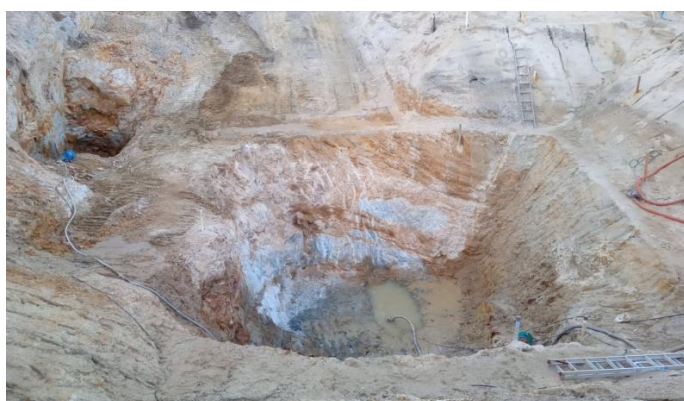
写真4 拡張後の注入トレンチ (R3. 12. 2)
