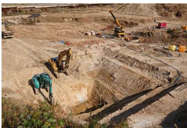
写真1 注入トレンチの拡張 (R3. 11. 15)
