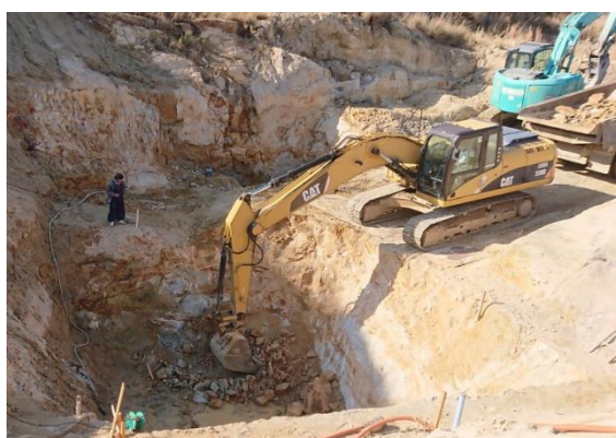
写真3 注入トレンチの拡張 (R3. 12. 2)
