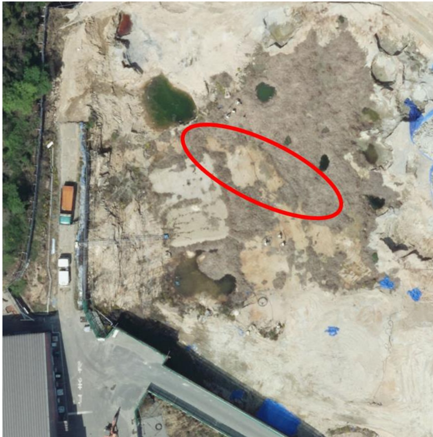
図1 油混じり水が点在していると考えられるエリア
