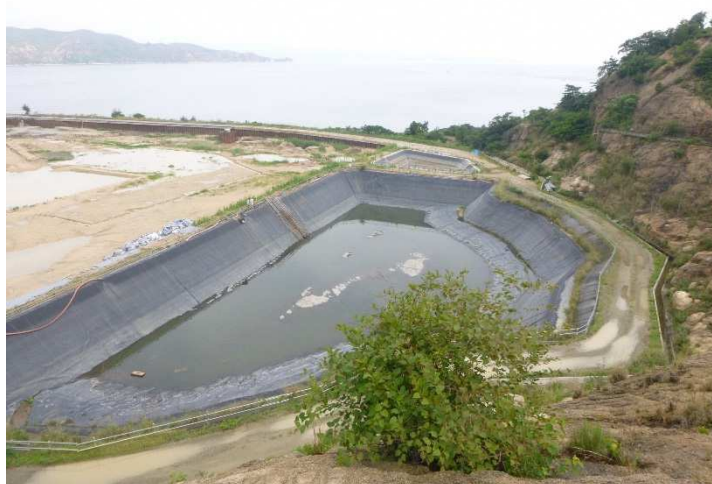
写真2 貯留トレンチ
