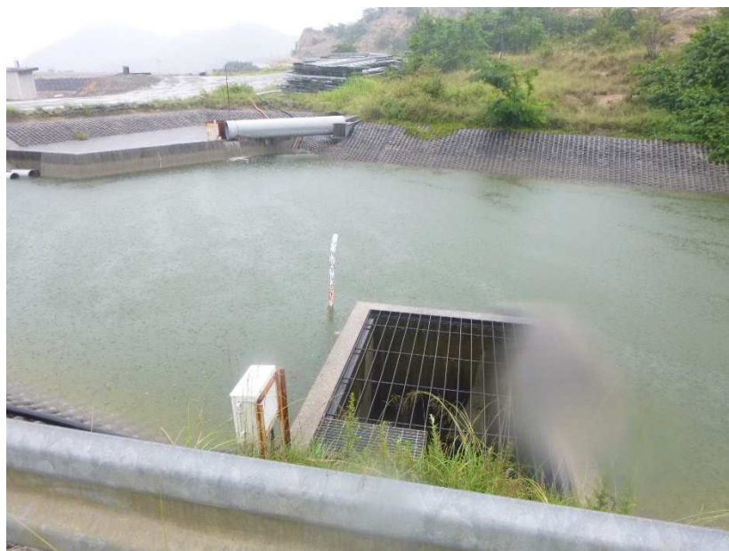
写真1 沈砂池2の呑口工
