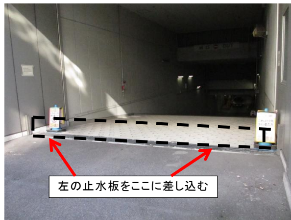
地下駐車場への浸水を防ぐ
