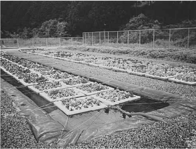
写真3 水質浄化施設
