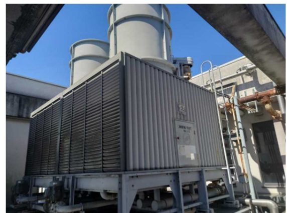
図2 モニタリング対象（冷却塔）外観
