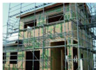
構造用パーティクルボード (製品名：Rex Board®)
