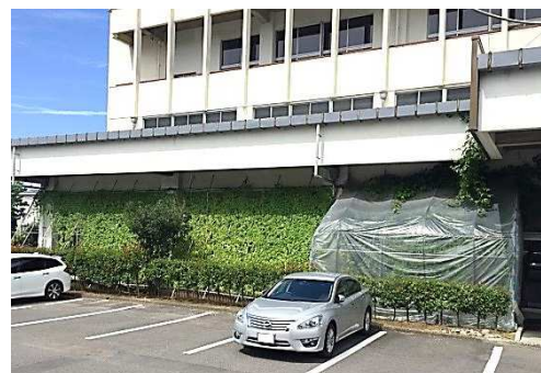
香川県農業協同組合 綾坂地区営農センター 様 (綾川町)
