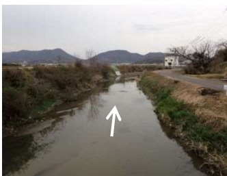
浜堂川JR浅津川橋梁下流 (高瀬川合流点から1.7km付近)
