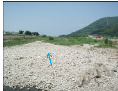
写真① 下流(国道11号付近)
