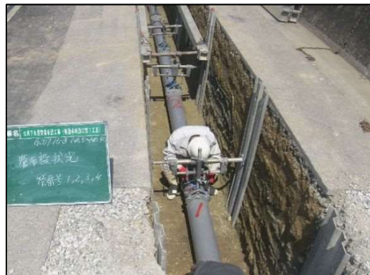
汚水管渠布設工事(善通寺市)
