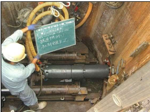
汚水管渠布設工事(坂出市)
