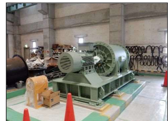
金倉川浄化センター送風機増設(県)
