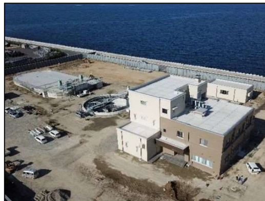
三本松浄化センター新設(東かがわ市)
