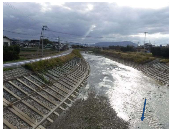
大東川改修後
