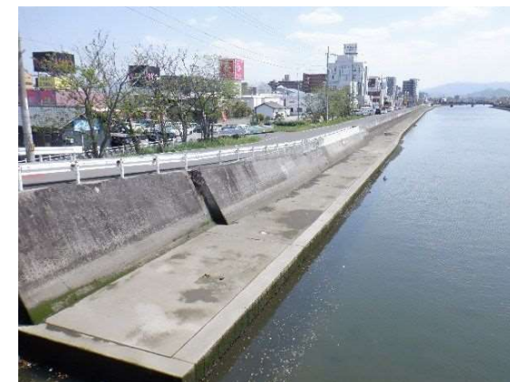
詰田川耐震化後
