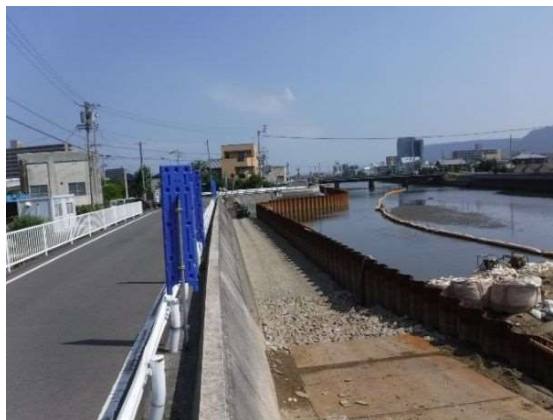
詰田川耐震化工事状況
