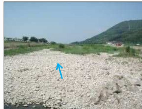
写真① 下流(国道11号付近)
