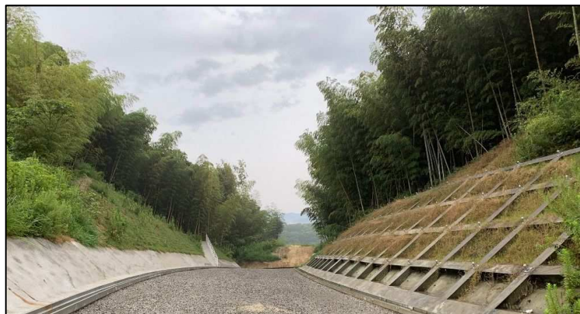
河川橋梁竣工
