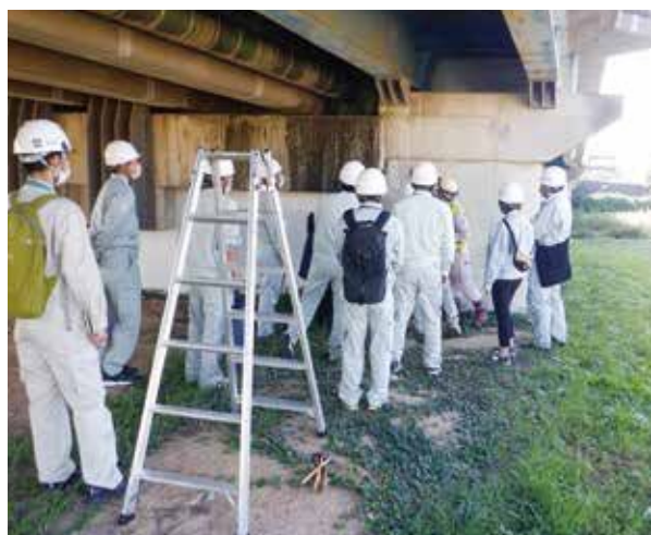
橋梁点検・補修(現地点検実習)
