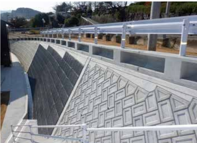
工事名 : 県道財田上高瀬線(財田工区) 地方特定道路整備工事 委託者 : 西讃土木事務所 場所 : 三豊市 財田町 財田上
