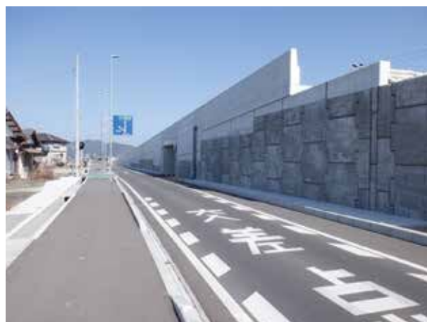
工事名 : 県道円座香南線 道路改築工事 委託者 : 高松土木事務所 場所 : 高松市 香南町 横井
