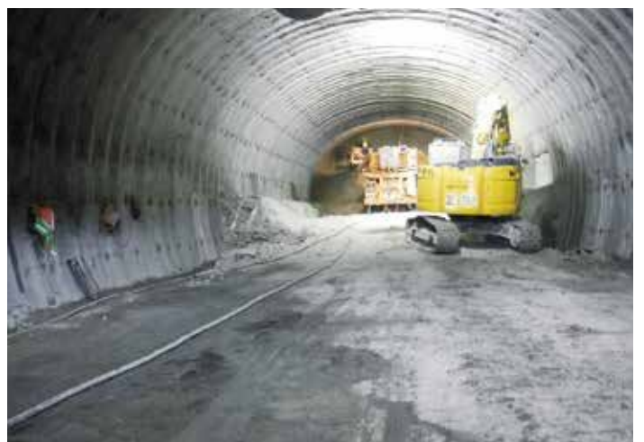
工事名 : 県道高松坂出線(五色台工区)道路改築工事 (五色台トンネル)(坂出側工区) 委託者 : 中讃土木事務所 場 所 : 坂出市 青海町
