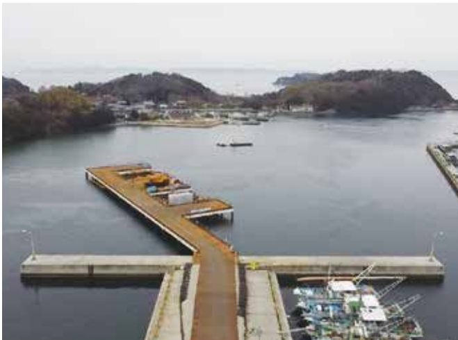
工事名 : (社会資本整備総合交付金) 町道沖之島線道路整備工事(橋梁下部工) 委託者 : 土庄町 場 所 : 小豆郡 土庄町 小江
