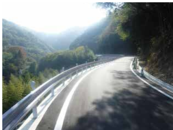
工事名 : 県道鹿庭奥山線(鹿庭北工区) 道路整備工事 委託者 : 長尾土木事務所 場所 : 木田郡 三木町 鹿庭
