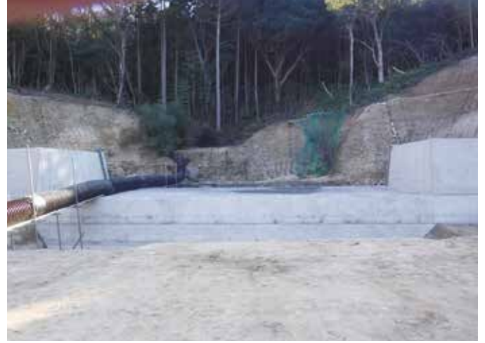
工事名 : 高尾戸川 事業間連携砂防工事 委託者 : 西讃土木事務所 場所 : 三豊市 詫間町 詫間
