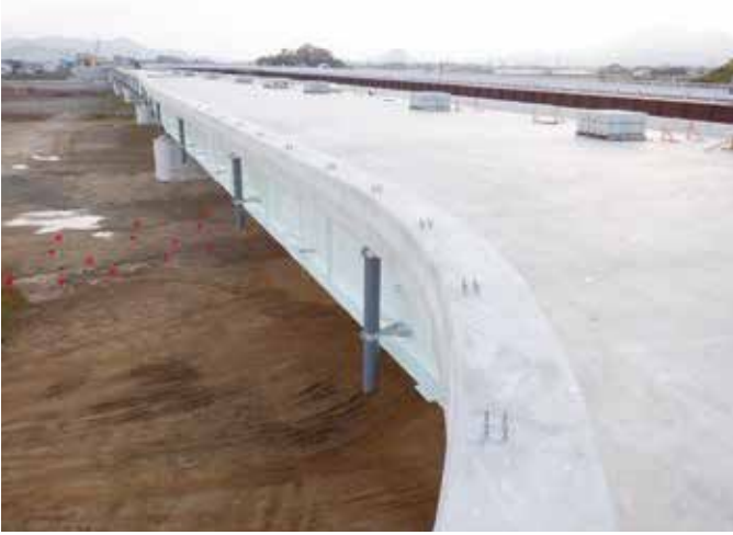
工事名 : ゼロ県債(道路メンテナンス事業) 県道善通寺綾歌線(中方橋)道路整備工事 委託者 : 中讃土木事務所 場所 : 丸亀市 川西町
