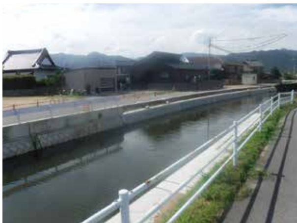
工事名 : 古川大規模特定河川工事(護岸工) 委託者 : 長尾土木事務所 場所 : 東かがわ市 引田
