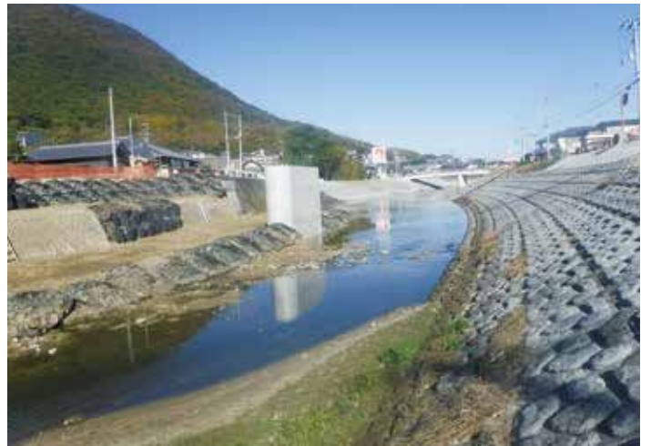
工事名 : ゼロ県債(防災・安全社会資本整備交付金) 広域河川大東川改修工事(新開橋下部工) 委託者 : 中讃土木事務所 場 所 : 丸亀市 飯山町 東坂元
