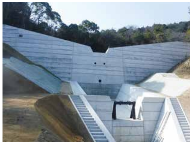
工事名 : (防災・安全社会資本整備交付金) 田口川 通常砂防工事(第2工区) 委託者 : 長尾土木事務所 場所 : 東かがわ市 帰来
