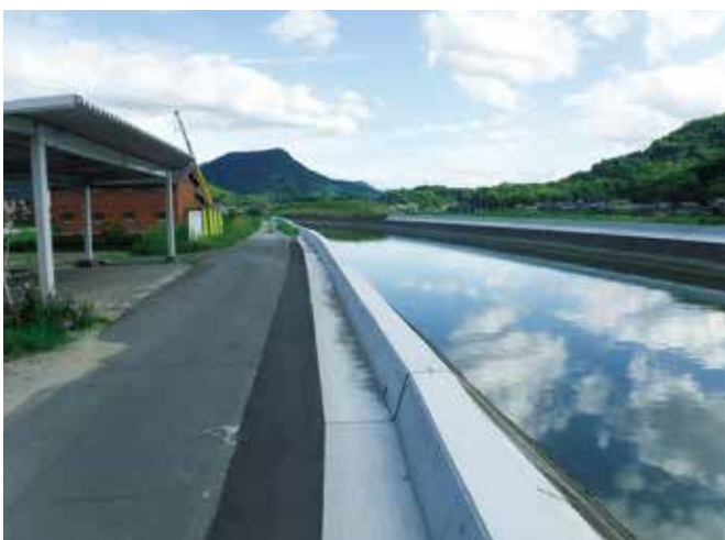
工事名 : (防災・安全社会資本整備交付金) 青海川津波等対策河川工事(第3工区) 委託者 : 中讃土木事務所 場 所 : 坂出市 大屋富町
