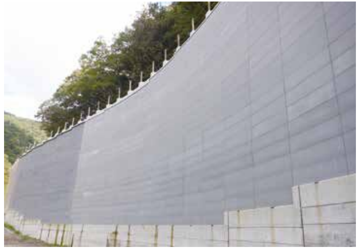
工事名 : 香東川総合開発事業 樺川ダム 付替市道建設工事(西岸線第44工区) 委託者 : 高松土木事務所 場 所 : 高松市 塩江町 安原上東
