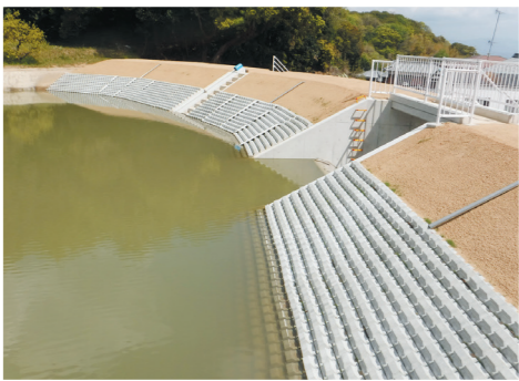
県営地域ため池総合整備事業実施後の空池(さぬき市)
