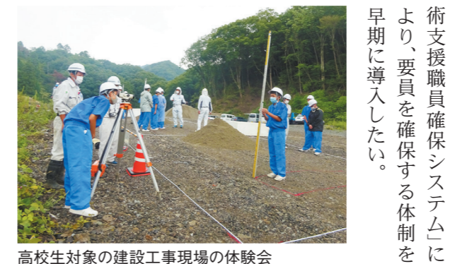
高校生対象の建設工事現場の体験会
