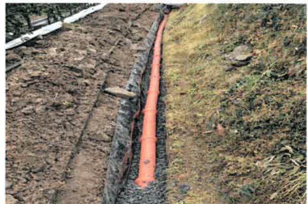
暗渠設置状況
